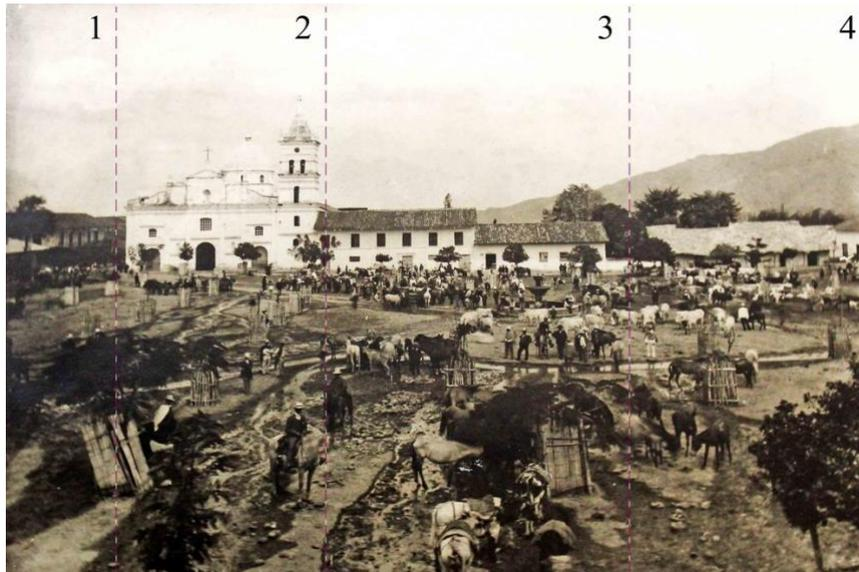
**Figura 8.** Técnicas coloniales presentes a principios del siglo XX. 1. Teja de barro y pies derechos. 2. Encalado. 3. Ladrillo encalado con abundantes vanos y teja de barro. 4. Bahareque con pocos y amplios vanos y cubierta de palma. Fotografía de base: “Ferias en la plaza de Bolívar”. S.a. (1909). Archivo de memoria visual de la biblioteca Darío Echandía del Banco de la República. Fuente: (Francel A. , *Historia y patrimonio de la periferia interior de Ibagué*, 2017, págs. 44-45)
